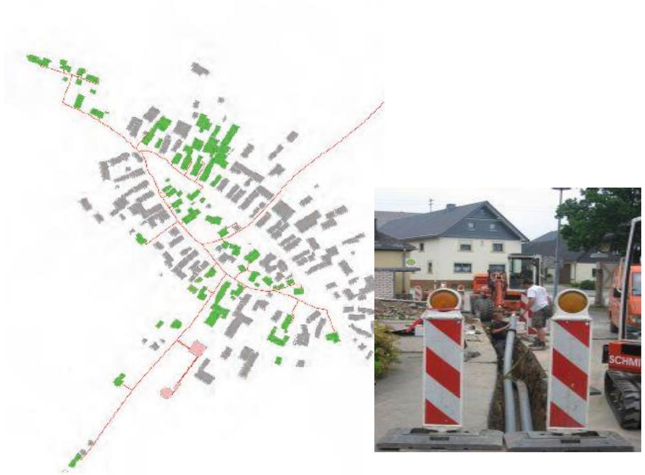
Über die Wärmeversorgung durch ein Nahwärmenetz wird eine der komfortabelsten Versorgungsmöglichkeiten für die Nutzer im Dorf bereitgestellt. Die Haushalte benötigen keinen eigenen Heizkessel mehr und auch kein Rohstofflager, wodurch zwei Räume im Haus für andere Zwecke genutzt werden können.
